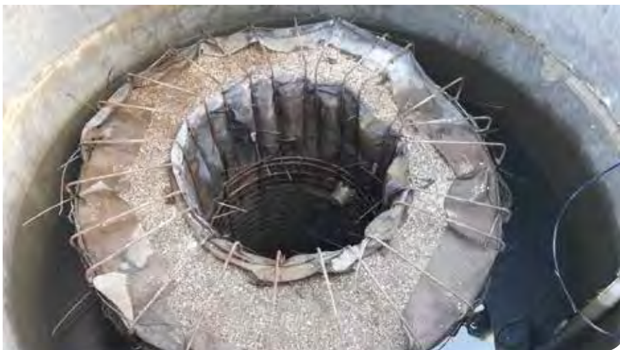
▲ Filter op basis van o.a. materiaal afkomstig van schelpen voor P-verwijdering (Denemarken).
